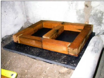
写真 04 ブリングボックス設置
