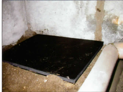
写真 02 盛土断熱板設置
