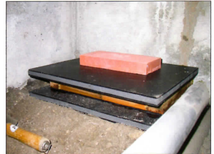
写真 06 床下設置状況
